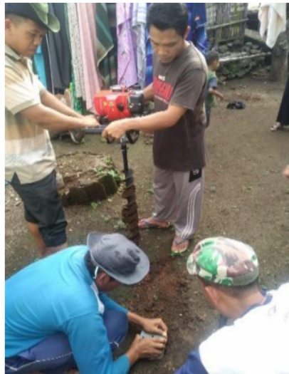
Gambar 3. Praktik pembuatan biopori oleh warga
