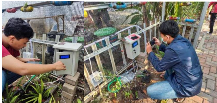
Gambar 4. Proses Instalasi di Taman Tosabu Kramas
