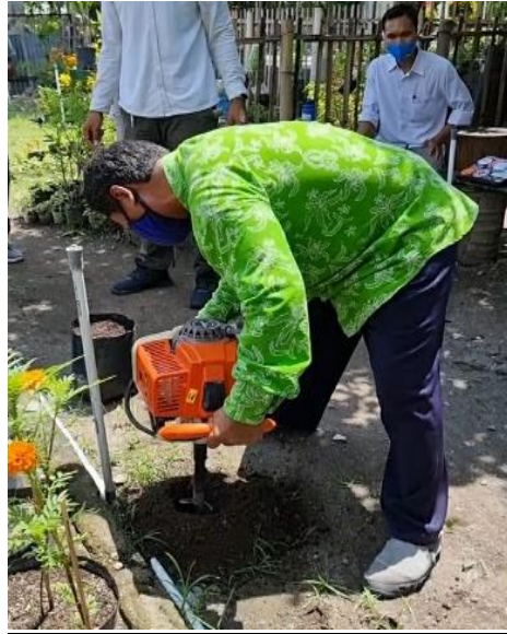
Gambar 2. Peragaan pembuatan lubang biopori dengan teknik bor oleh Tim PKM
