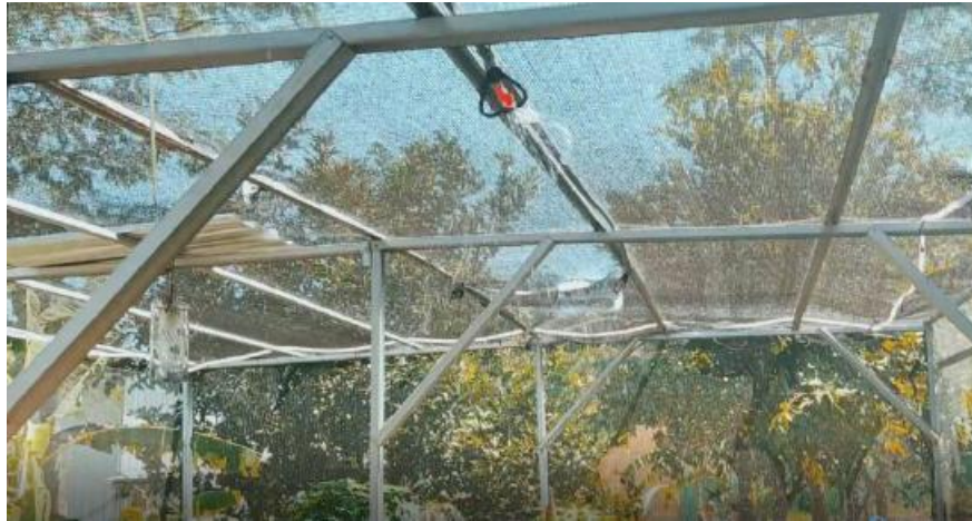
Gambar 9. Proses penyiraman menggunakan nozzle sisi atas
