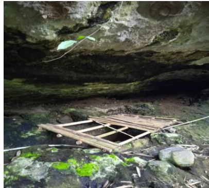
Gambar 1. Kondisi Mata Air Yang Belum Tertutup Baik
