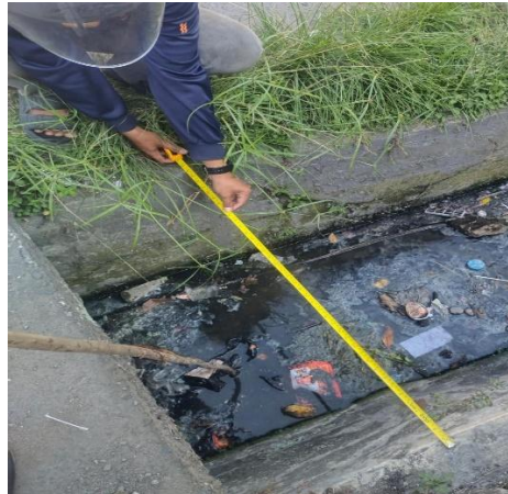
Gambar 4. Kondisi saluran tanpa sedimentasi pada segmen 4
