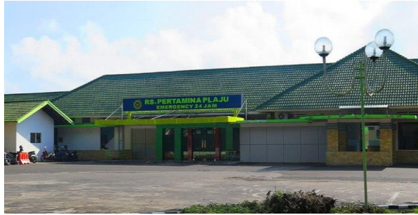
Gambar 2. Bangunan Rumah Sakit di kompleks Pertamina Plaju Palembang (Foto dokumentasi pribadi, 2019).
