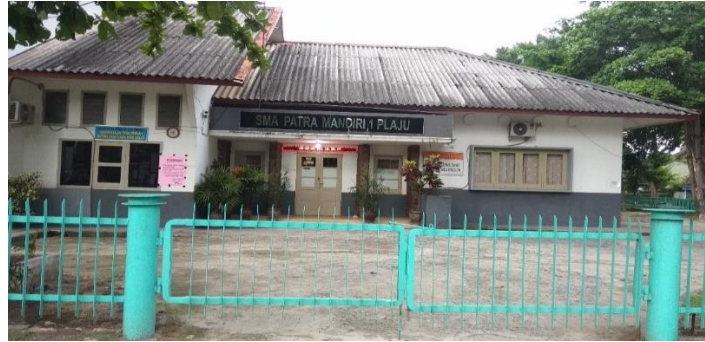
Gambar 2: Bangunan Sekolah SMA Patra Mandiri 1 Palembang (Dok. pribadi, 2019)
