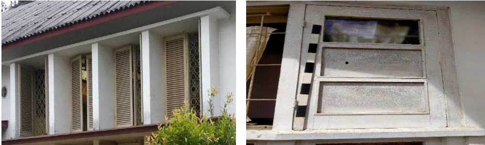
Gambar 4 Bagian jendela pada gedung olahraga di SMA Patra Mandiri 1 (Dokumentasi pribadi, 2020)
