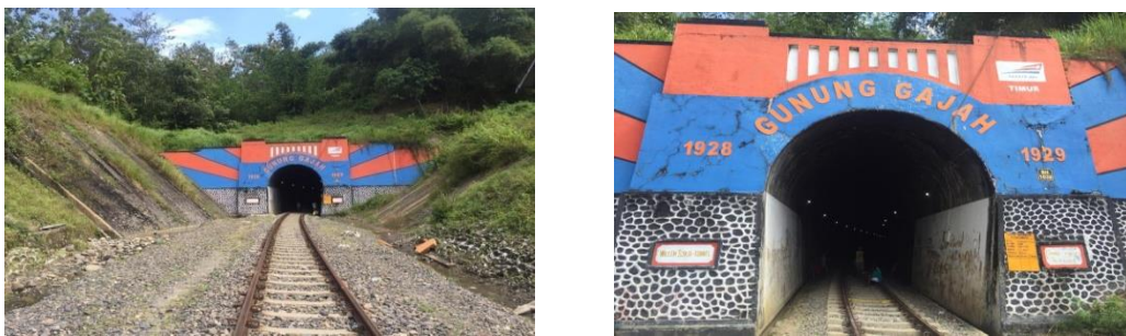
Gambar 1. Terowongan Gunung Gajah Kec, Lahat (Sumber: Dokumentasi pribadi, 2020).
