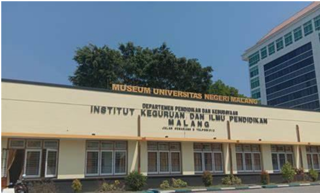
Gambar 1. Tampak belakang gedung A.14 Museum Edukasi UM, dilihat dari gerbang depan Rektorat UM Sumber: Arsip museum, 2023
