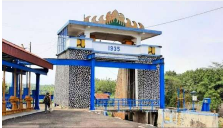
Gambar 5. Kondisi Bangunan Agroguruh yang saat ini Sumber: Dokumen Trimurjo Heritage, 2020
