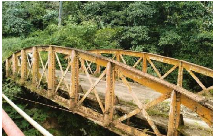
Gambar 3. Jembatan Baja di Pekon, Kecamatan Batu Brak
