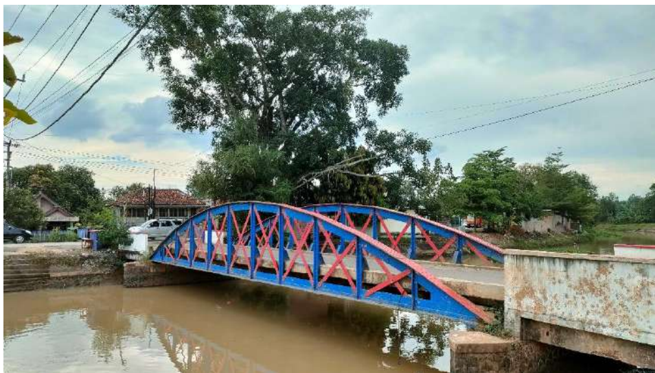
Gambar 2. Kondisi Jembatan Baja Tahun 2024
