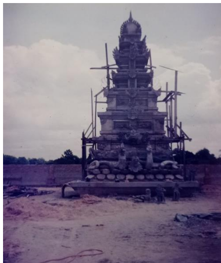
Gambar 2. Foto Pura pada Masa Awal Pembangunan
