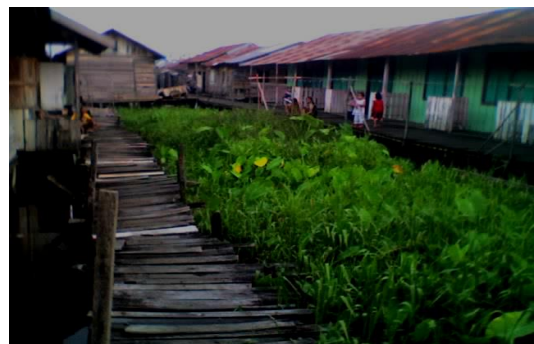
Gambar 5: Foto Jalan Titian Pada Bantaran Sungai
