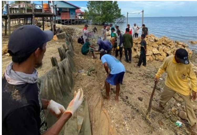
Gambar 14. Warga bergotong royong membangun turap (Sumber: Dokumentasi Penelitian, 2023)
