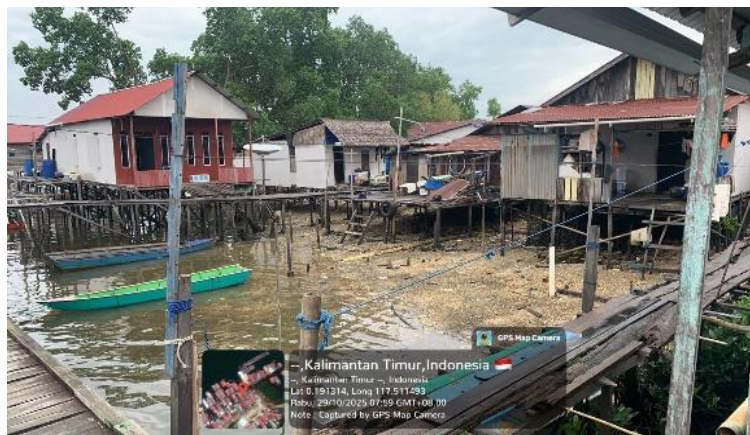
Gambar 4. Rumah warga yang ditinggikan dan di pindahkan (Sumber: Dokumentasi Penelitian, 2026)
