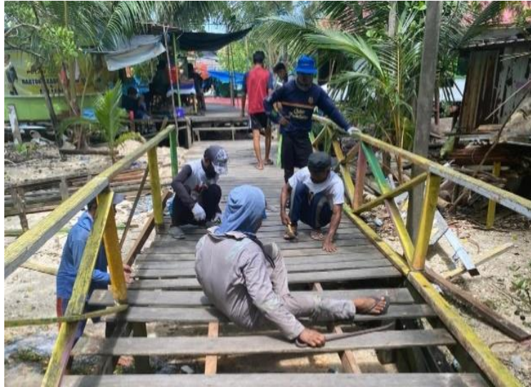
Gambar 11. Perbaikan akses jalan dan jembatan secara gotong royong (Sumber: Dokumentasi Penelitian, 2023)
