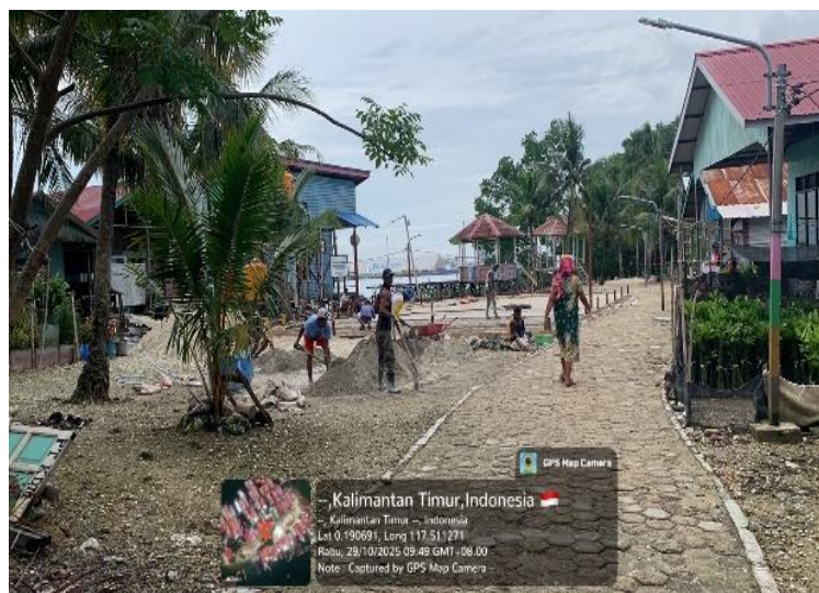
Gambar 10. Gotong royong perbaikan fasilitas umum lapangan voli (Sumber: Dokumentasi Penelitian, 2025)
