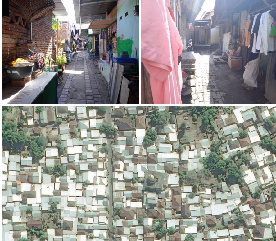
Gambar 2. Kondisi Permukiman Penduduk di Lingkungan Babakan Timur (Sumber: Dokumen Peneliti, 2022)
