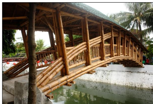
Gambar 9. Konstruksi jembatan dari bambu (Sumber: ikons.id, 2020)
