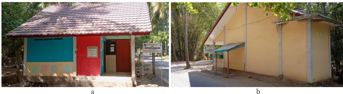
Gambar 1. Bangunan Sekolah PAUD Raudhatul Jannah NW berstandar tahan gempa Tampak Depan (a) dan Tampak Belakang (b) (Sumber: Dokumen Peneliti, 2023)
