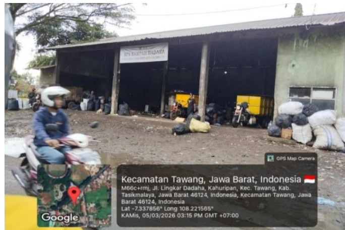
Gambar 3. Kondisi Fasilitas SPA Sampah Dadaha (Sumber: Dokumen peneliti, 2026)
