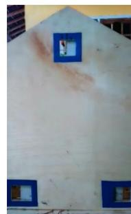
Gambar 8. Ventilasi Oven Pengeringan Daun
