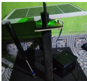
Gambar 9. Instalasi Rangkaian dengan Panel Surya
