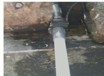
Gambar 8. Pemasangan alat pada PDAM
