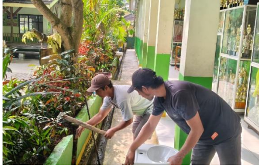
Gambar 4. Pemasangan wastafel untuk mendukung kebiasaan mencuci tangan
