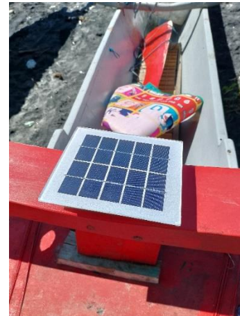
Gambar 7. Pemasangan Alat di Perahu Nelayan
