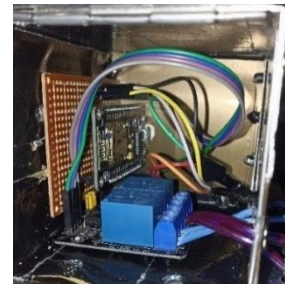
Gambar 10. Pemasangan ESP8266 dan Relay DC
