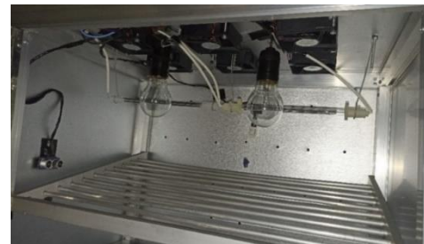
Gambar 11. Pemasangan Sensor Ultrasonik Sensor DHT22 Kipas dan Pemanas
